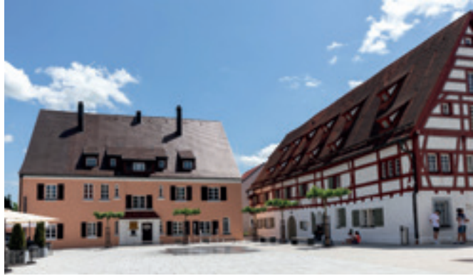
Spitalplatz Bopfingen mit Wasserspiel; rechts das Museum im Seelhaus
